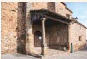
Fachada sur de la iglesia de S. Miguel
